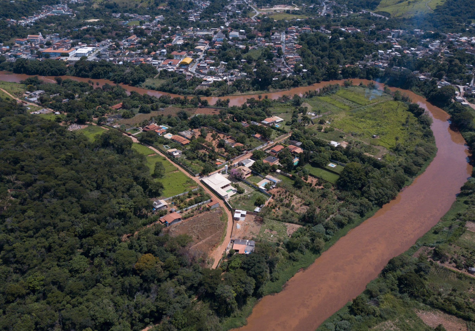
Crime da Vale na barragem da Mina Córrego do Feijão em Brumadinho-MG. Colonia Santa Izabel. Foto: Nilmar Lage.
